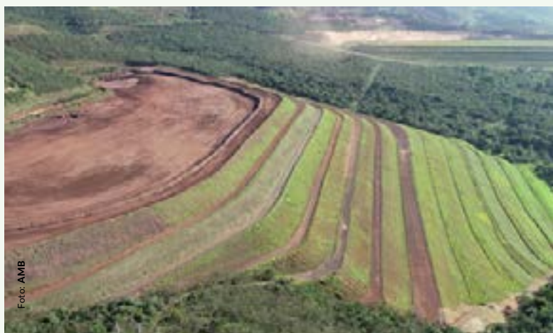
Barragem Mina Serra Azul.
