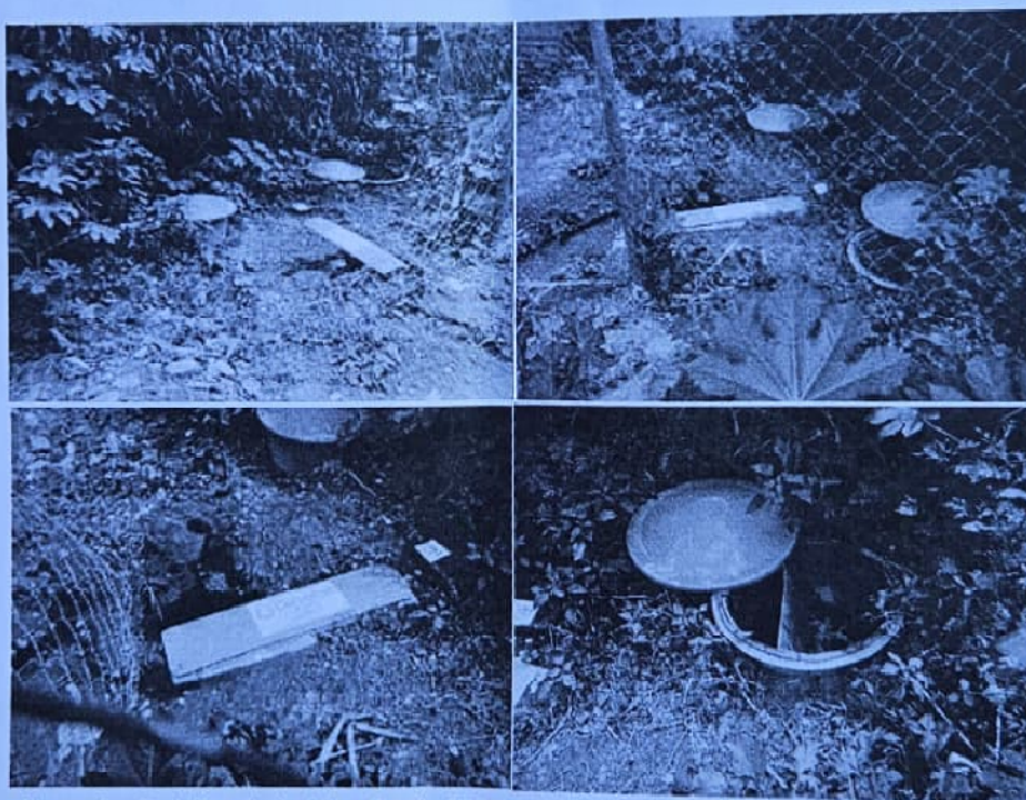
Figura 3 – Detalhe da instalação da ETE, verificação do estado de conservação dos materiais e equipamentos
