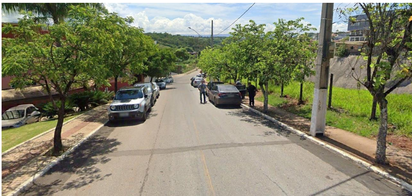
Figura 11: Praça Yayá Sampaio e calçada rua Irineu Lamounier, nota-se ausência de rebaixo acessível nas calçadas e de sinalização podotátil em acordo com a NBR9050/2020. Anéis permeáveis das árvores existentes em dimensões menores que o recomendado e desejável. Fonte: Google Street View, 2023.
