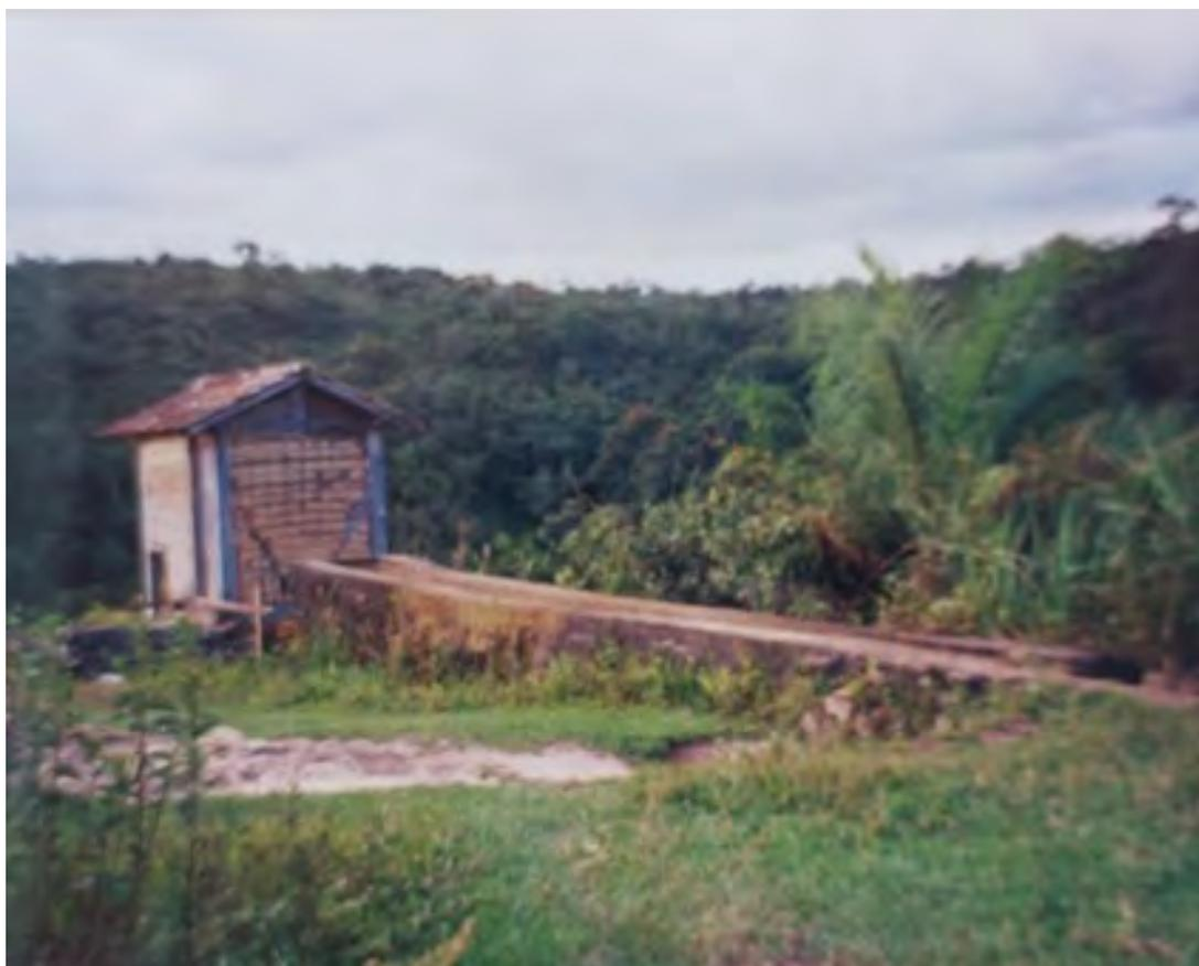
**Imagem 38:** Moinho na década de 1990. Detalhe de parede de pau-a-pique e rego cimentado. Fonte: Acervo pessoal de moradores.
