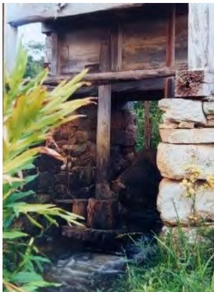
**Imagem 39:** Moinho na década de 1990. Detalhe do eixo do mastro e rodízio em pleno funcionamento. Estrutura em pedra e madeirame. Fonte: Acervo Associação Comunitária de Aranha.
