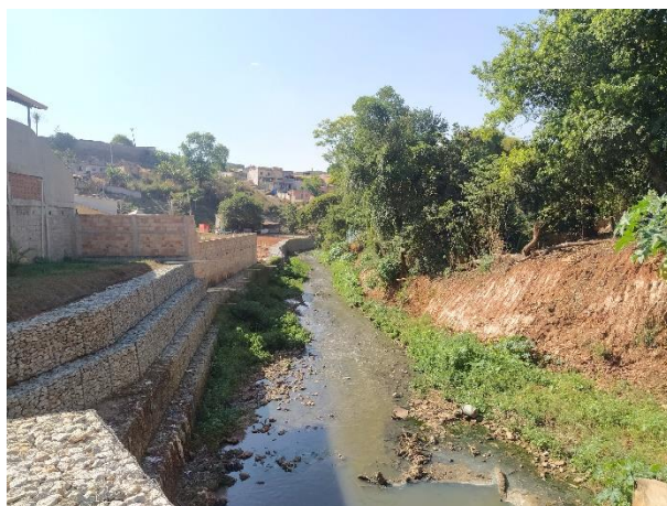
Foto 30: Córrego Igarapé (Machado) com implantação de muro de contenção.
