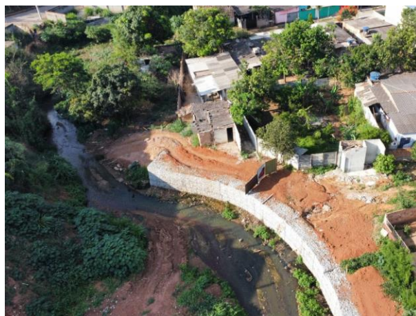
Foto 35: Vista aérea do córrego Igarapé (Machado) com implantação de muro de contenção.
