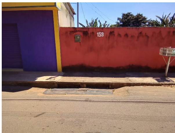
Foto 73: Bueiro tampado na rua Arcanja.
