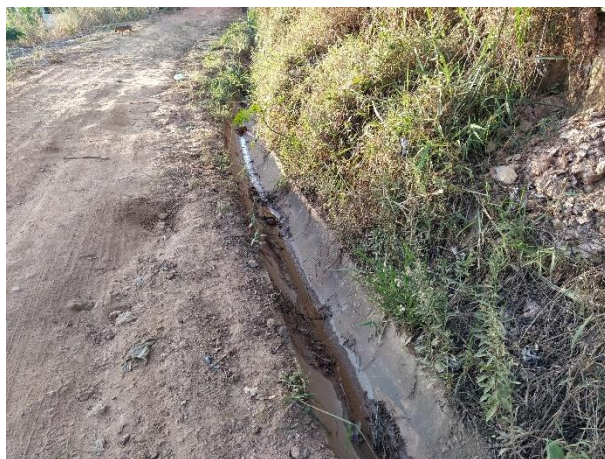
Foto 118: Sistema de drenagem pluvial da rua Jacomino de Moura.
