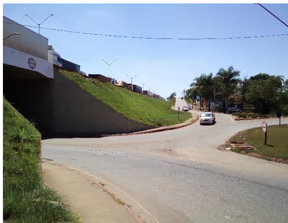
Foto 78: Rua Perina Venceslau do Prado no bairro São Sebastião, próximo à trincheira da BR-381.
