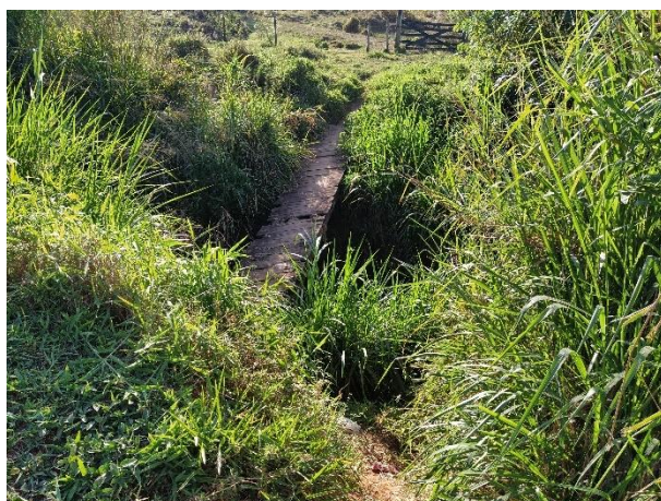
Foto 28: Passarela sobre o córrego Fundo entre os bairros Novo Horizonte e São Sebastião.
