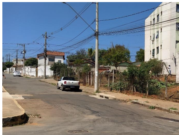
Foto 11: Ampliação do sistema de drenagem pluvial na rua Maranhão esquina com avenida Brasília.
