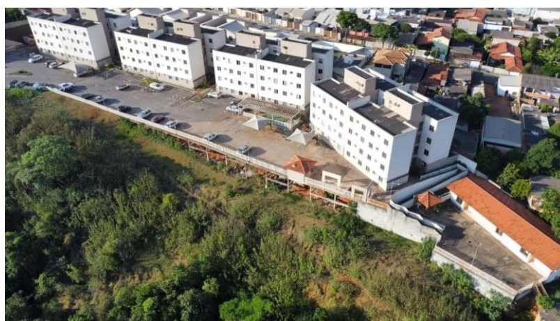
Foto 142: Vista aérea de área de risco de deslizamento nas proximidades do Condomínio Terras de Minas.
