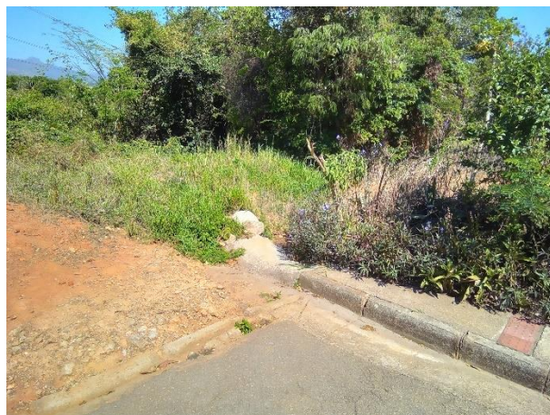
Foto 91: Área de escoamento pluvial na rua Perdiz.
