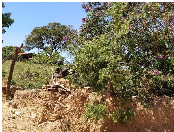
Foto 125: Local de queda de árvore na rua Arlindo Cândido.
