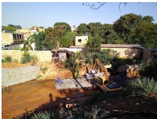
Foto 128: Córrego Igarapé (Machado) com implantação de muro de contenção.
