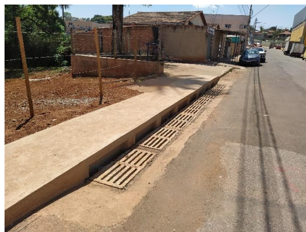
Foto 9: Ampliação do sistema de drenagem pluvial com a instalação de novos bueiros na avenida Brasília.
