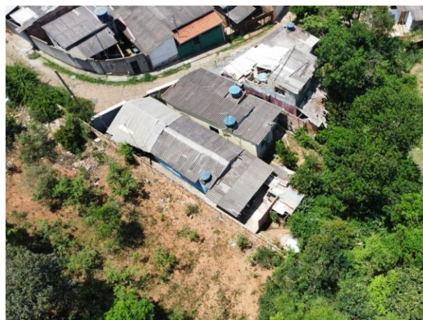
Foto 146: Vista aérea da área de risco de deslizamento na rua Bidoca.
