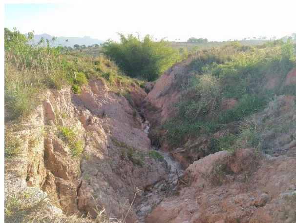
Foto 115: Voçoroca em terreno nos bairros Canarinho e Panorama.
