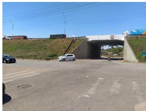
Foto 64: Rua Bernardino da Silva Couto no bairro São Sebastião, próximo à trincheira da BR-381.
