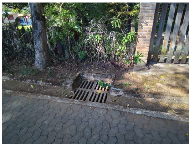
Foto 97: Sistema de drenagem pluvial da alameda Flamboyant.
