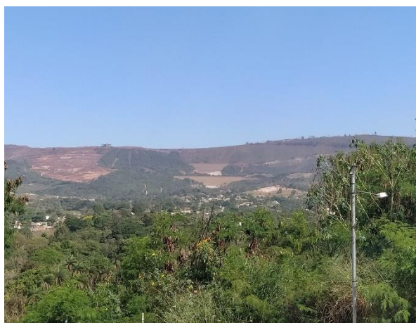
Foto 161: Barragens B1-Auxiliar e B2 – Mina Tico-Tico da Mineração Morro do Ipê.
