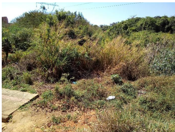
Foto 92: Voçoroca ao final da rua Perdiz coberta por vegetação em porção à montante no terreno.
