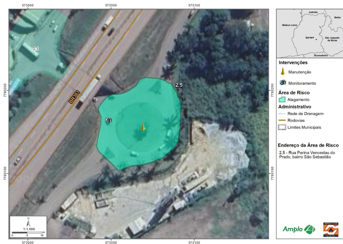
Figura 23: Área de Risco 2.5. Local de ocorrência de alagamento.
