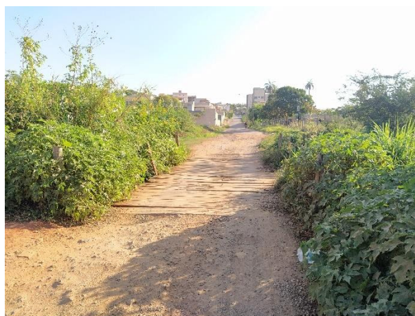
Foto 27: Ponte na rua Adenir Thomás do Prado, no bairro São Sebastião.
