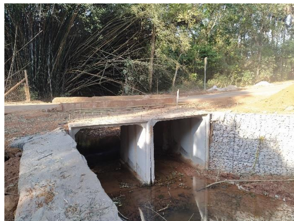
Foto 21: Ampliação da ponte sobre o córrego Estiva com alargamento para a passagem de água.
