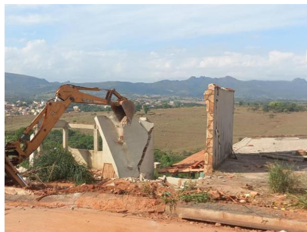
Foto 121: Edificação demolida na rua Jacomino de Moura no dia 24/10/2023.
