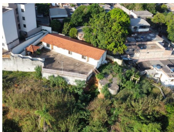
Foto 141: Vista aérea de área de risco de deslizamento nas proximidades do Condomínio Terras de Minas.
