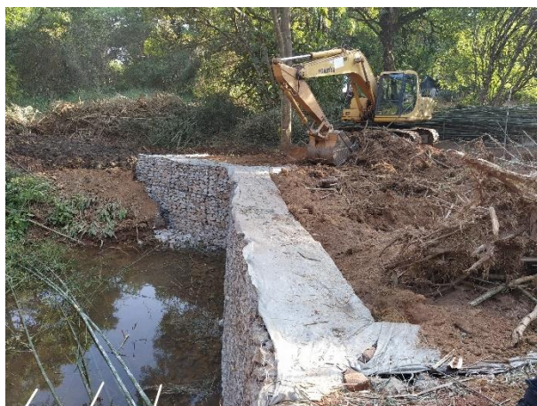
Foto 22: Instalação de muro de arrimo de gabião no córrego da Estiva nas proximidades da Portaria do Condomínio Fazenda Solar.
