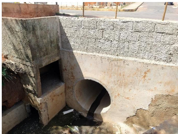
Foto 10: Ampliação do sistema de drenagem pluvial.
