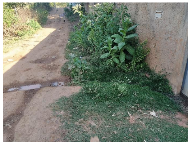
Foto 101: Canal criado para o escoamento de água pluvial na rua São Lázaro.
