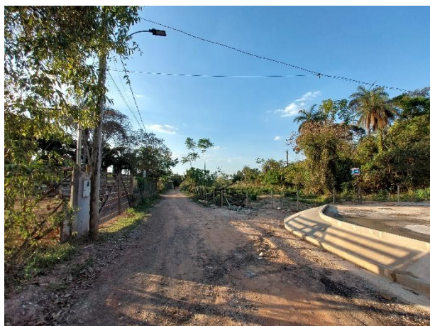
Foto 88: Porção da rua D sem pavimentação.
