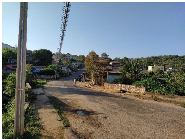
Foto 24: Ponte sobre o córrego Fundo na avenida Central entre os bairros Novo Horizonte e Panorama.
