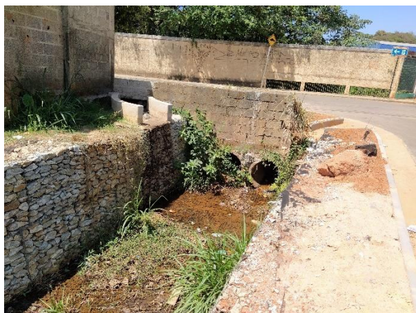
Foto 42: Curso d'água sem denominação com muro de arrimo em suas margens na rua Carlinda Francisca de Oliveira.
