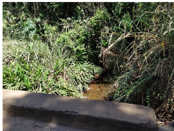
Foto 7: Córrego do Rego ou Vista Alegre no bairro Cidade Nova.
