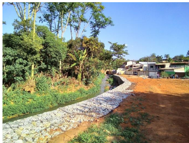
Foto 127: Córrego Igarapé (Machado) com implantação de muro de contenção.
