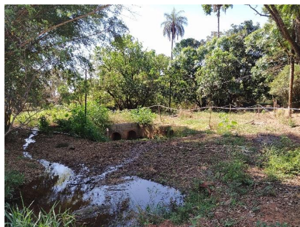
Foto 2: Infraestrutura de drenagem instalada no córrego da Olaria no bairro Candelária.
