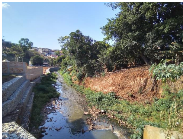
Foto 126: Córrego Igarapé (Machado) com implantação de muro de contenção e limpeza de talude.
