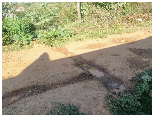
Foto 102: Canal criado para o escoamento de água pluvial na rua São Lázaro.
