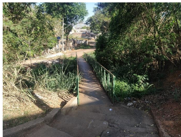
Foto 31: Ponte sobre o córrego Igarapé (Machado) entre os bairros Jardim das Roseiras e Juscelino Kubitschek.
