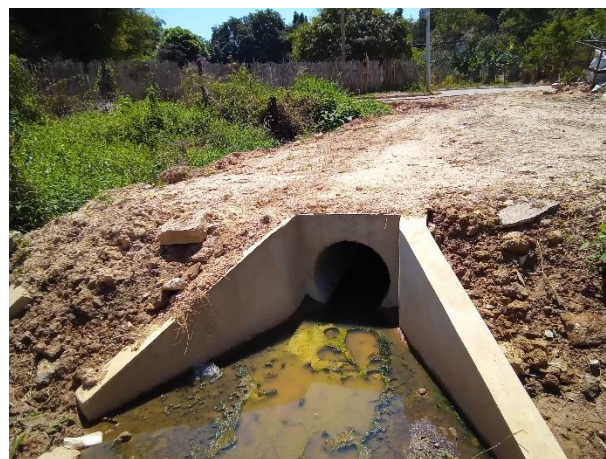
Foto 59: Ampliação do sistema de drenagem pluvial na rua do Serro no bairro Jequitibá.
