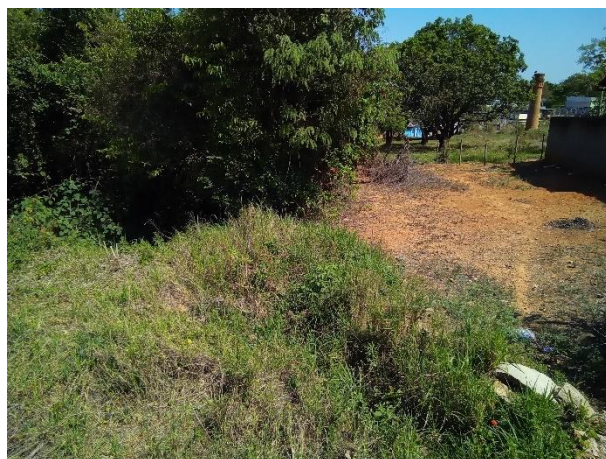
Foto 93: Voçoroca ao final da rua Perdiz coberta por vegetação em porção à jusante no terreno.
