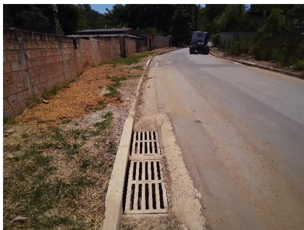
Foto 58: Ampliação do sistema de drenagem pluvial com a instalação de novos bueiros na rua do Serro no bairro Jequitibá.
