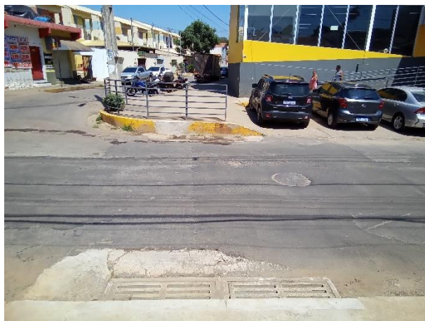
Foto 69: Ampliação do sistema de drenagem pluvial com a instalação de novos bueiros na avenida Miguel Paes.
