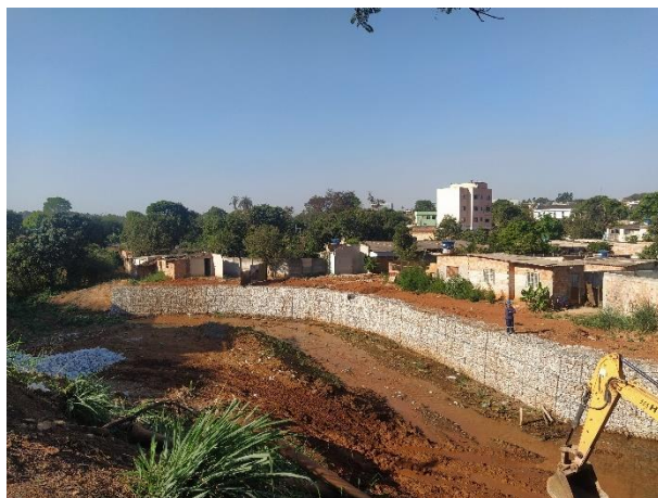
Foto 32: Córrego Igarapé (Machado) com implantação de muro de contenção.
