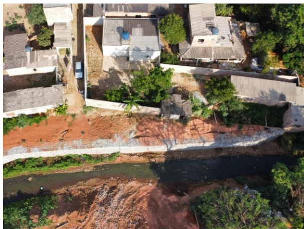
Foto 130: Vista aérea do córrego Igarapé (Machado) com implantação de muro de contenção.
