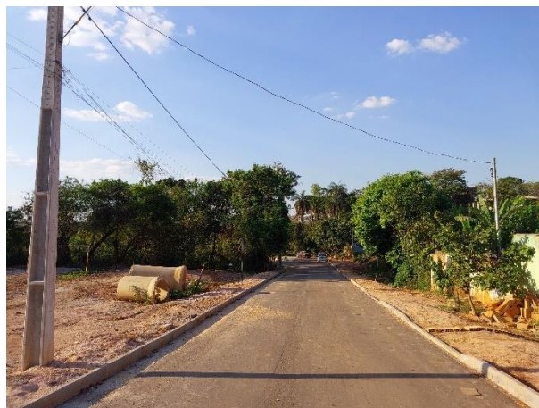
Foto 87: Porção da rua D recém pavimentada.
