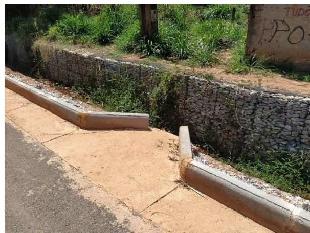
Foto 43: Área para o escoamento da água pluvial na rua Carlinda Francisca de Oliveira.
