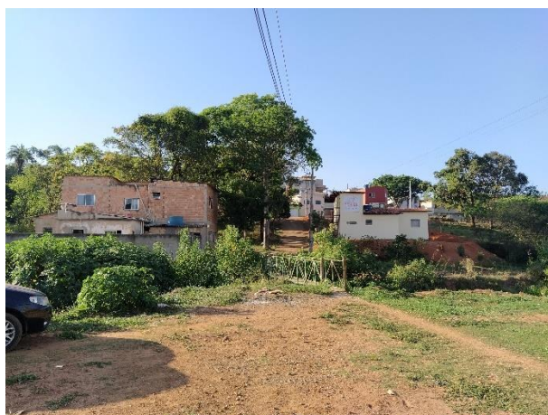
Foto 26: Passarela reposicionada sobre o córrego Fundo entre os bairros Novo Horizonte e Panorama.
