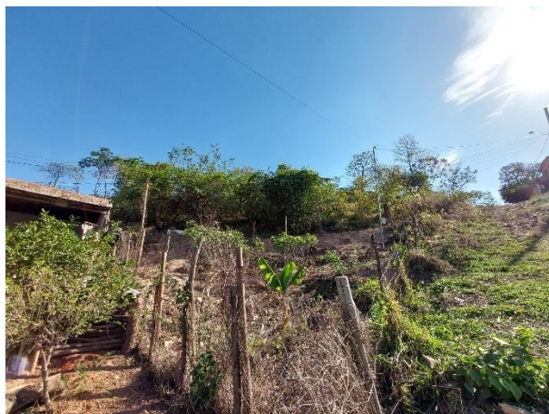
Foto 147: Área de deslizamento na rua São Pedro no bairro Nova Esperança.
