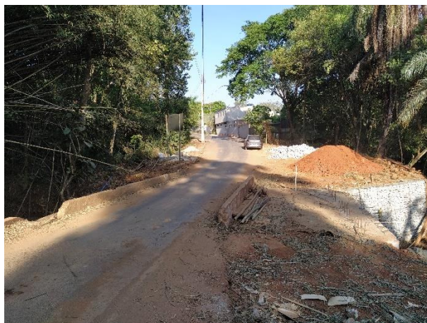
Foto 20: Obra na ponte sobre o córrego Estiva, na estrada Dezessete, próximo à Portaria do Condomínio Fazenda Solar.
