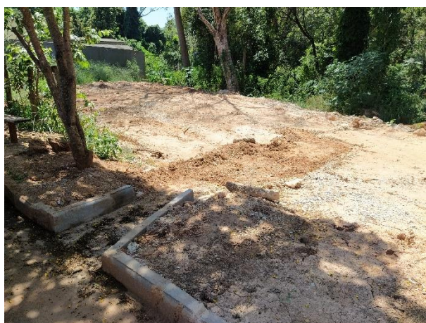
Foto 44: Área para o escoamento da água pluvial na rua Carlinda Francisca de Oliveira.
