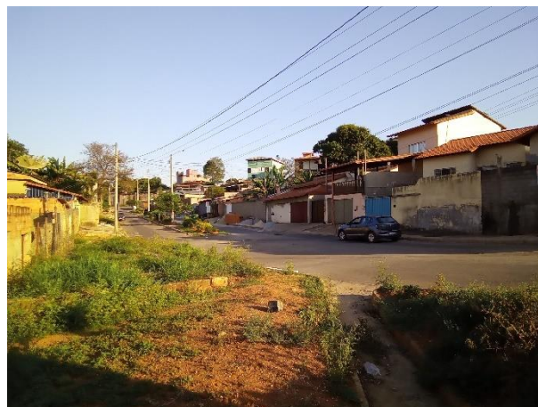
Foto 83: Área de escoamento pluvial na avenida José de Souza França.
