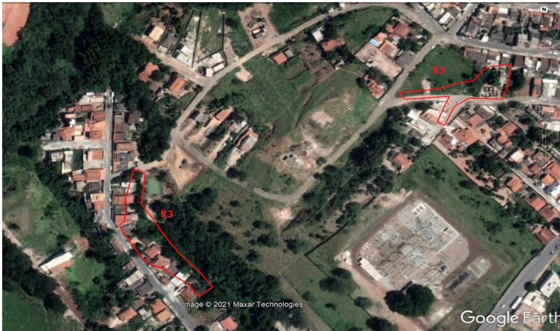
Figura 3 - Área de risco de encosta no Bairro Progresso II
