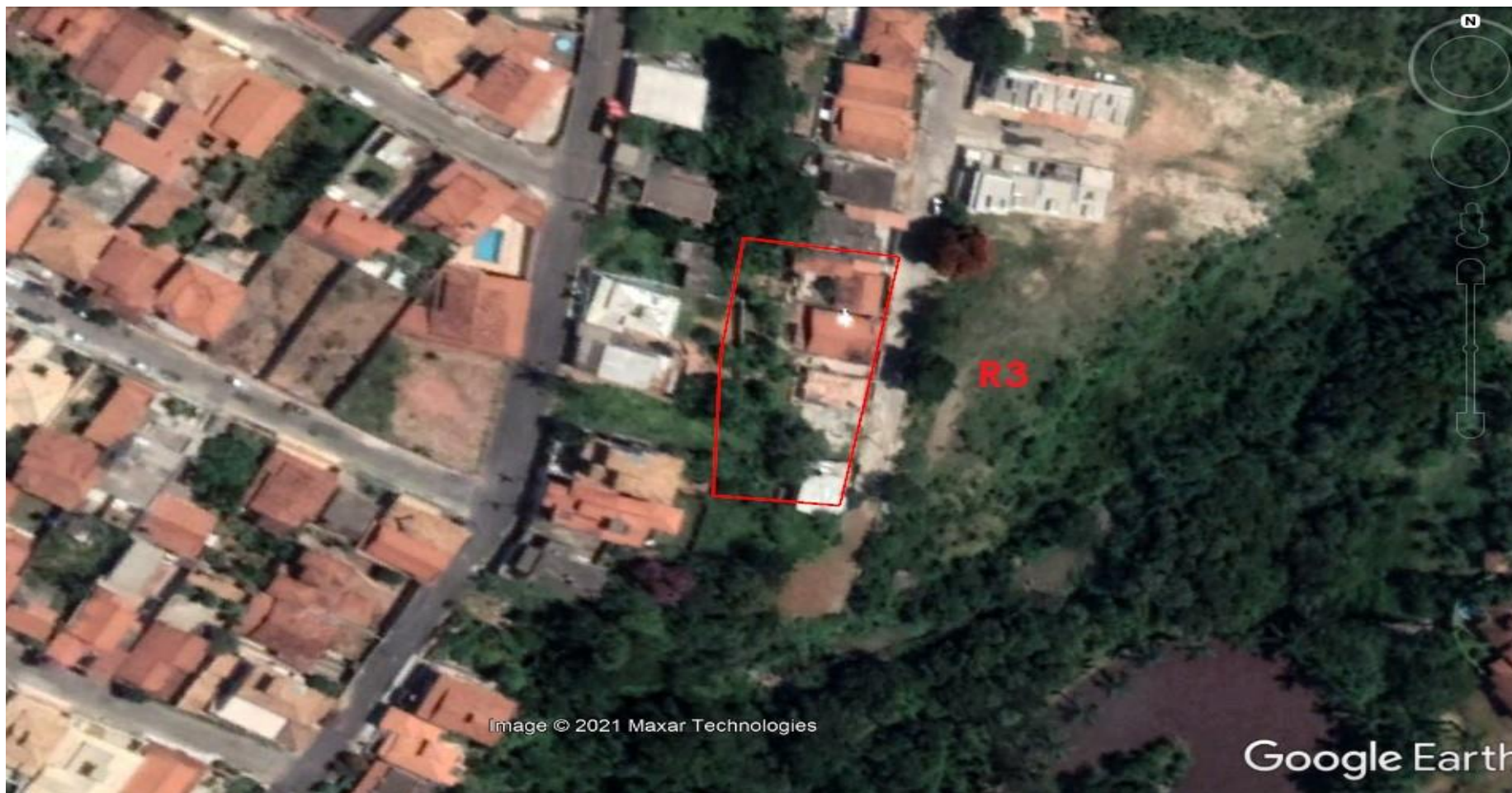
Figura 4 - Área de risco de encosta no Bairro Grajaú.
