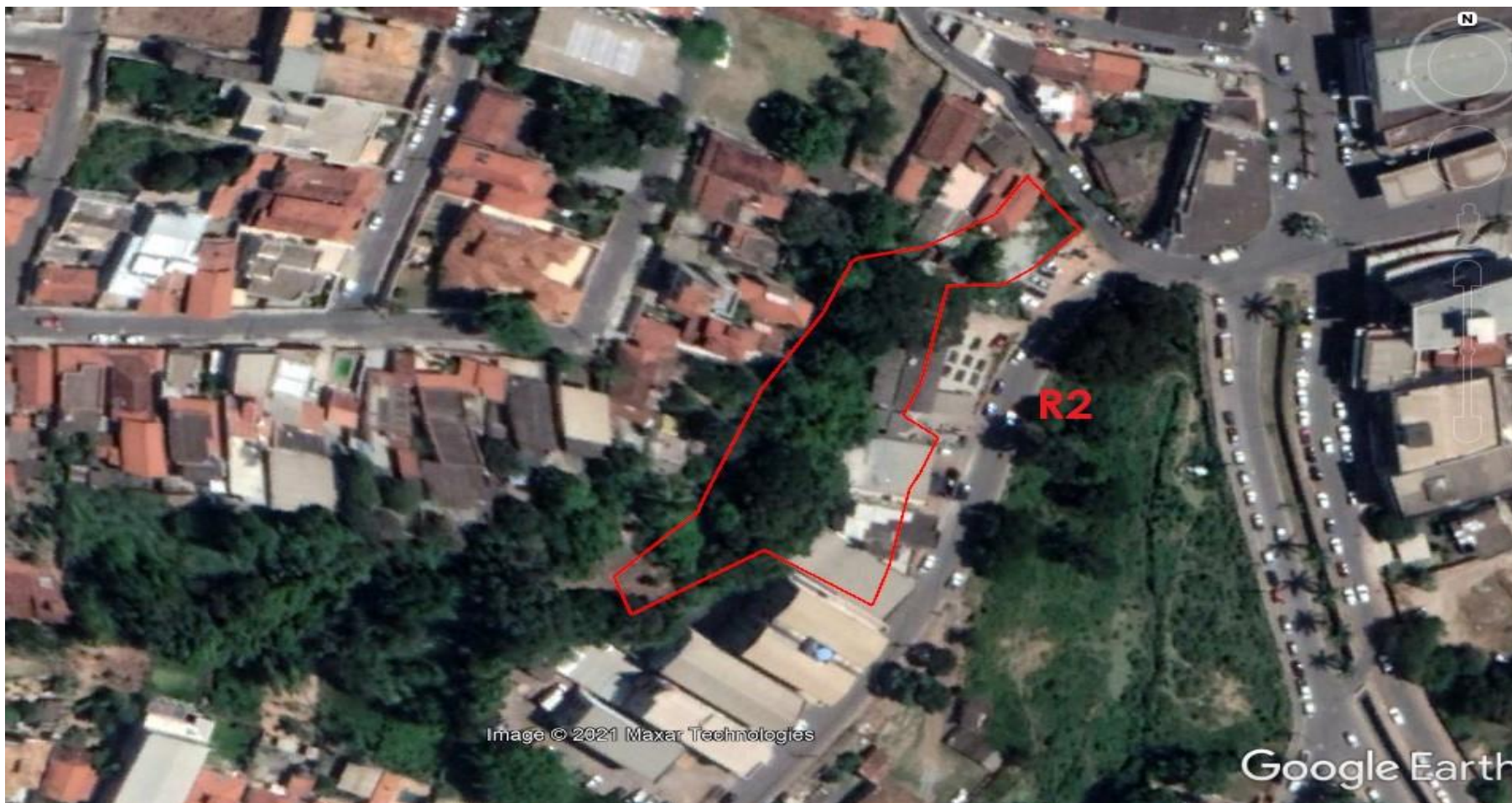
Figura 5 - Área de risco de encosta no Bairro de Lourdes
