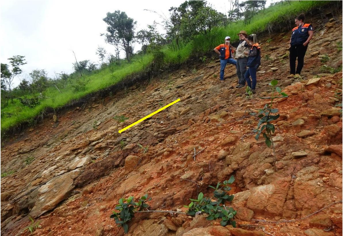
Figura 19 - Fotografia em 2022 da cicatriz de movimento de massa ocorrido em 2020 na rua de Londres. Destaque para a superfície de deslizamento paralela à foliação metamórfica da rocha e à superfície da encosta (seta amarela).
