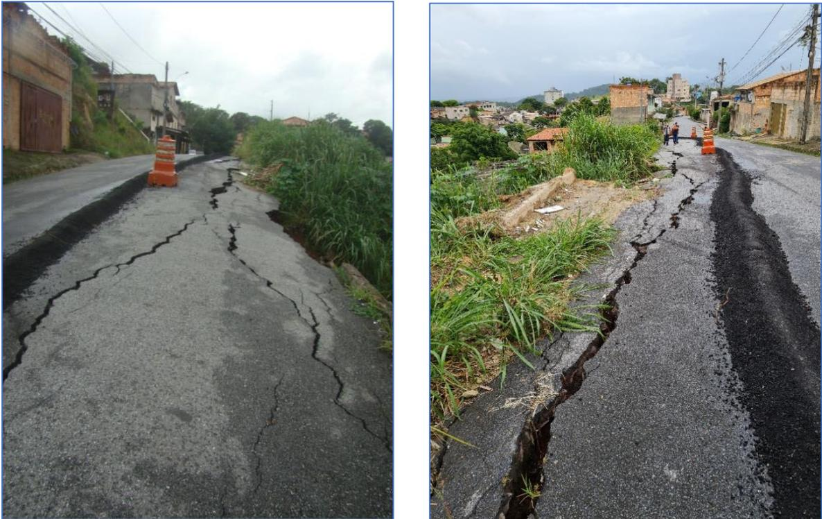
Figura 23 “a” e “b” - Destruição do pavimento asfáltico resultantes do movimento de massa gravitacional envolvendo materiais do talude (aterro) e da encosta na pista de rolamento da Rua Irajá. Esquerda vista de W para E e direita vista de E para W.
