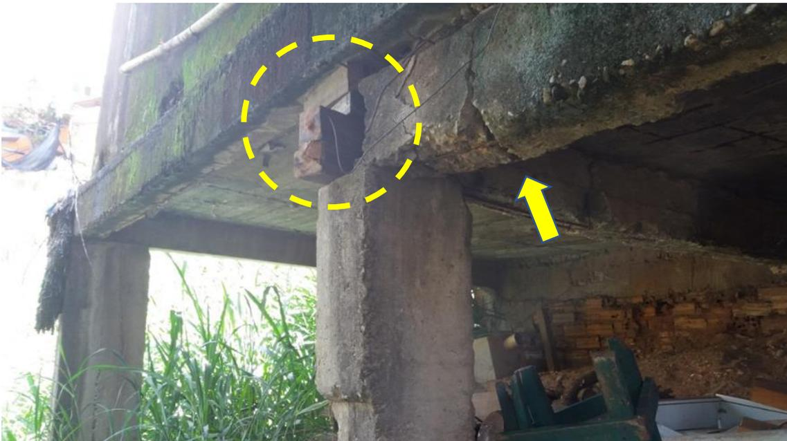
Figura 17 - Construções precárias com a utilização de artifícios como apoiam em "calços" improvisados para apoiar vigas novas e antigas, já parcialmente deformadas, possivelmente refletindo mobilização no substrato (CENACID, 2020).
