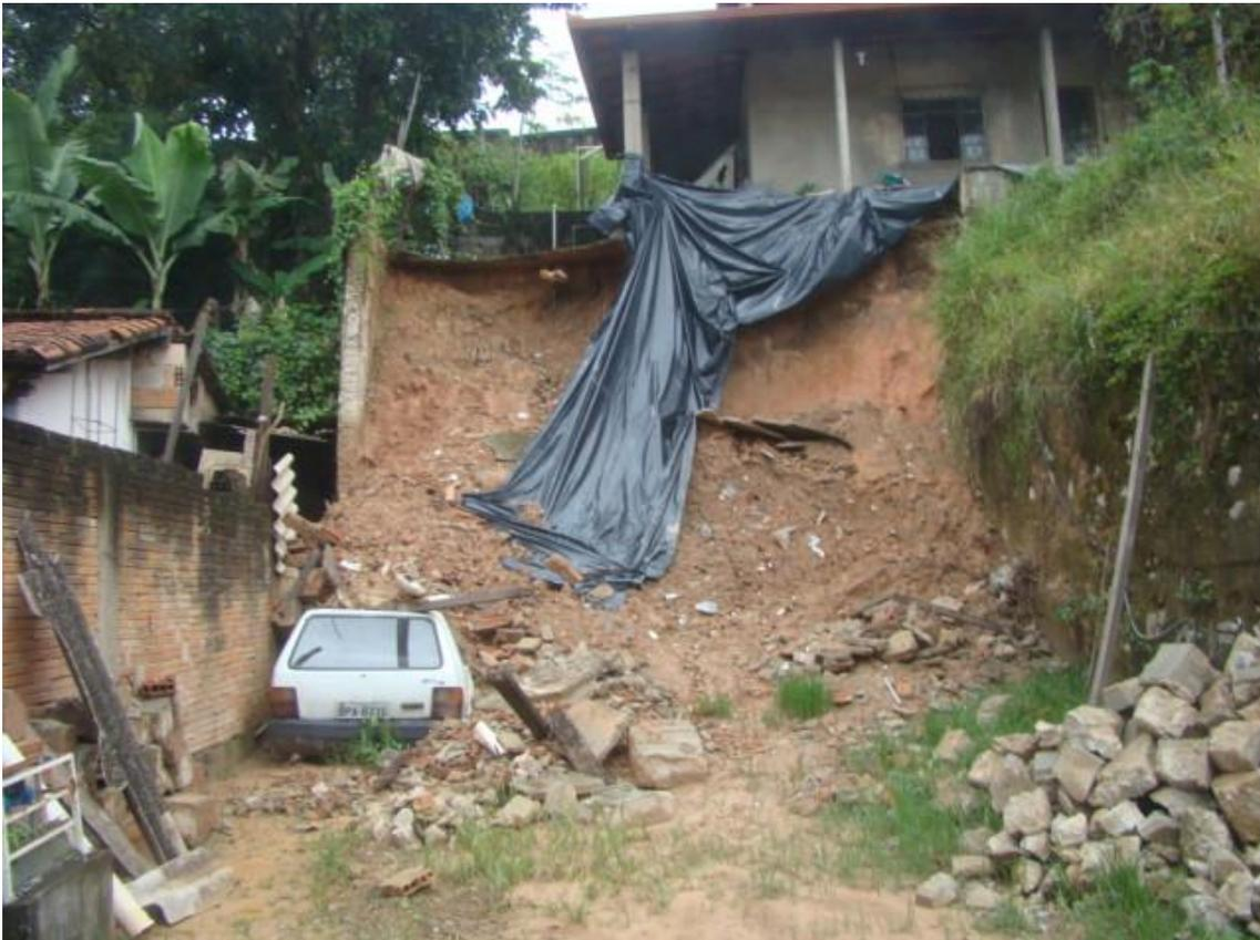
Figura 22 - Veículo soterrado e edificação afetada parcialmente por movimentos de massa gravitacionais ocorridos na encosta e aterro, a montante da pista de rolamento. Da Rua Irajá.
