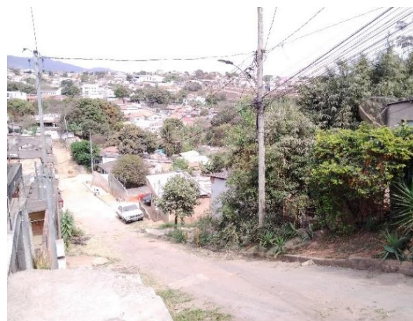
Foto 62: Rua Francisco Monteiro Lara no bairro Industrial.
