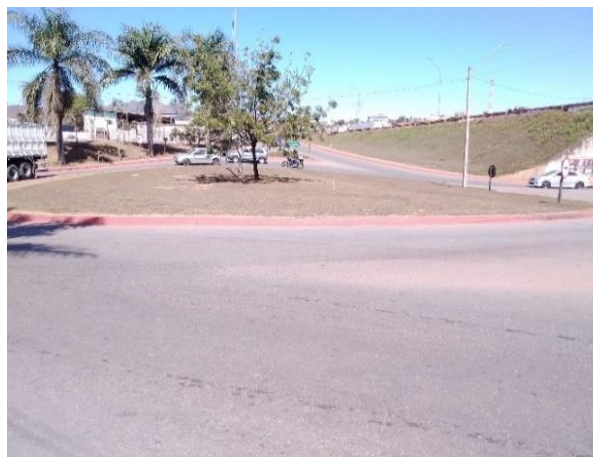
Foto 35: Trincheira da BR-381, centro de Igarapé.
