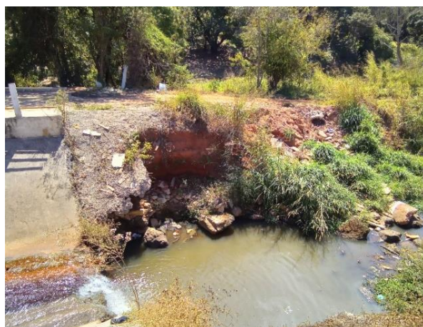
Foto 51: Córrego Fundo na avenida Waldomiro Nunes Ferreira, esquina com avenida Getúlio Vargas no bairro Padre Eustáquio.
