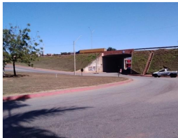
Foto 36: Trincheira da BR-381, centro de Igarapé.
