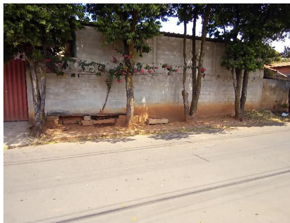
Foto 31: Marca de alagamento em muro na rua Arcanja no bairro Cidade Nova.
