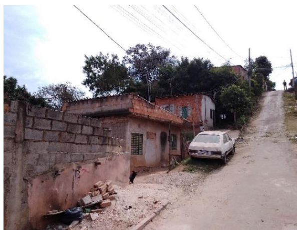
Foto 61: Rua Francisco Monteiro Lara no bairro Industrial.
