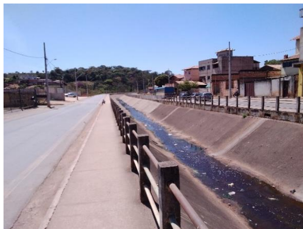
Foto 7: Avenida Waldomiro Nunes Ferreira no bairro Padre Eustáquio.
