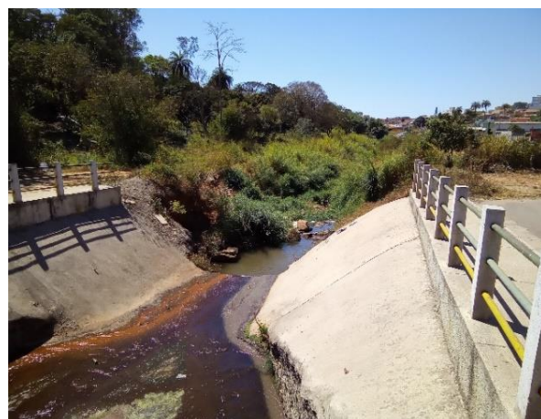
Foto 52: Córrego Fundo na avenida Waldomiro Nunes Ferreira, esquina com avenida Getúlio Vargas no bairro Padre Eustáquio.
