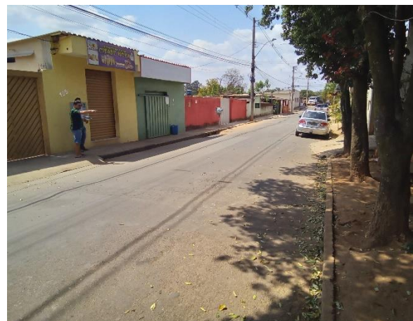
Foto 32: Presença de mofo na base dos muros possivelmente causada pelos alagamentos no bairro Cidade Nova.
