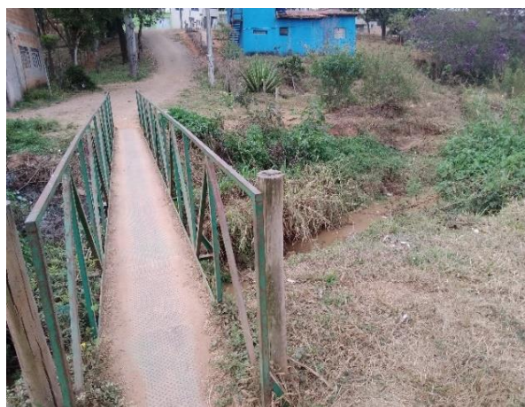
Foto 13: Ponte sobre o córrego Fundo entre os bairros Novo Horizonte, Panorama e São Sebastião.
