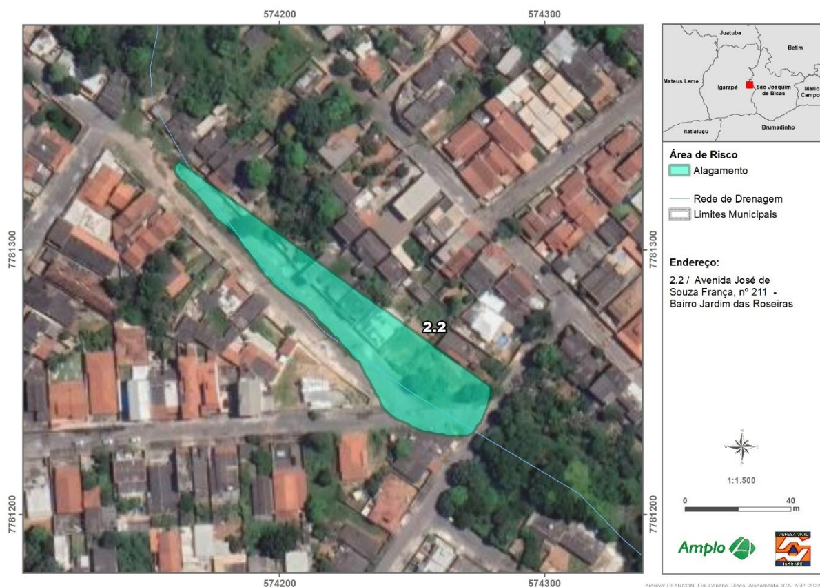
Figura 18: Área de Risco 2.2. Local de ocorrência de alagamento.
