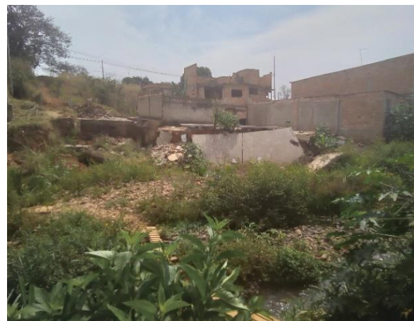
Foto 60: Local de ocorrência de deslizamentos às margens do córrego Igarapé (Machado).
