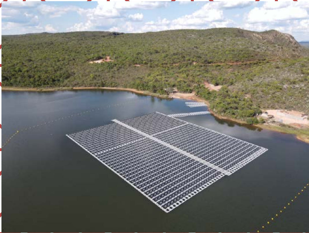
Fotografia da Usina Veredas Sol e Lares, em processo de construção. Registro feito pelo consórcio de engenharia responsável pelas obras.
