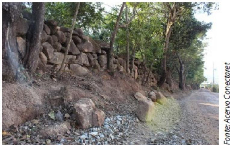
**Figura 6:** Muro de Pedras em Córrego do Feijão - Pedras soltas devido ao tráfego de caminhões
